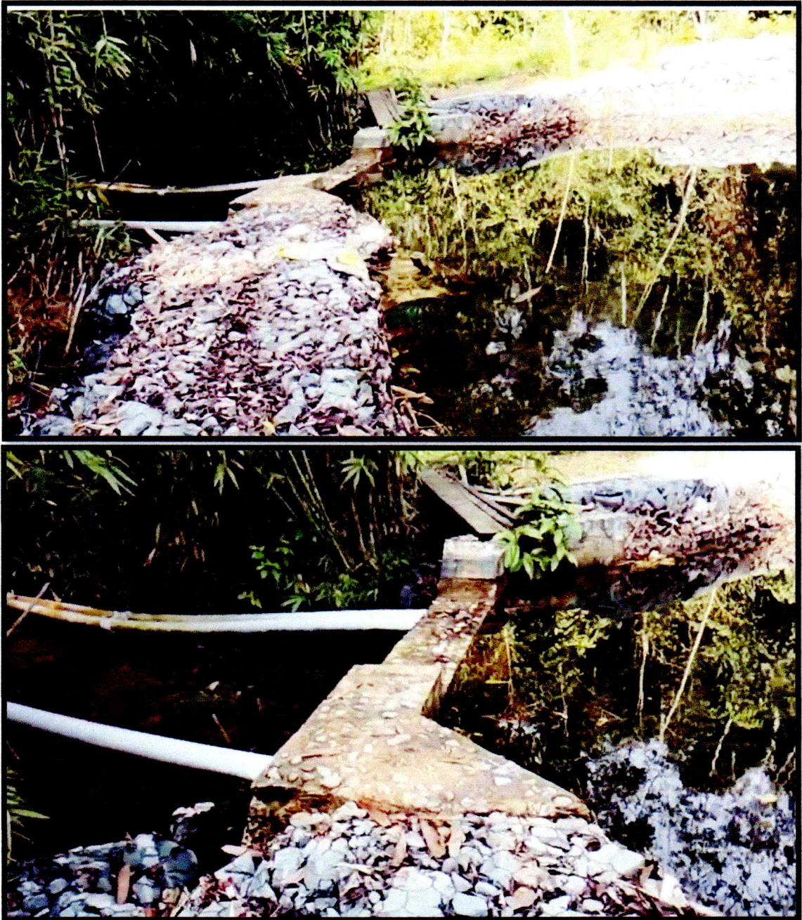
Bangunan Penangkap (Intake)
